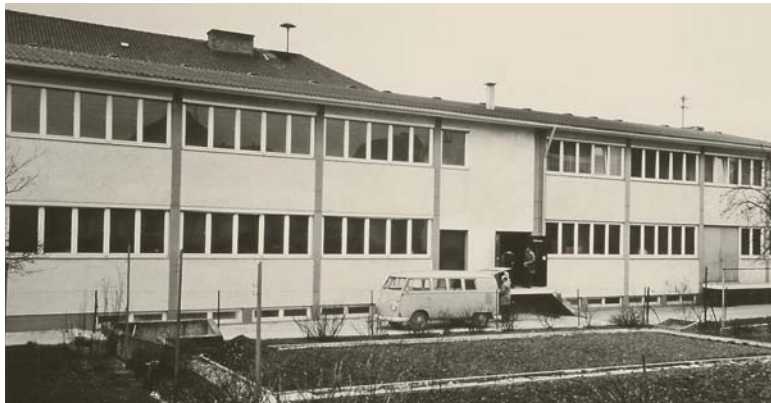
1965/66 | Produktionsgebäude in der Klosterstraße
