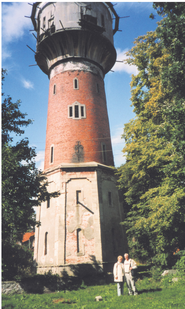
Der Wasserturm in Cranz, aufgenommen 2003
